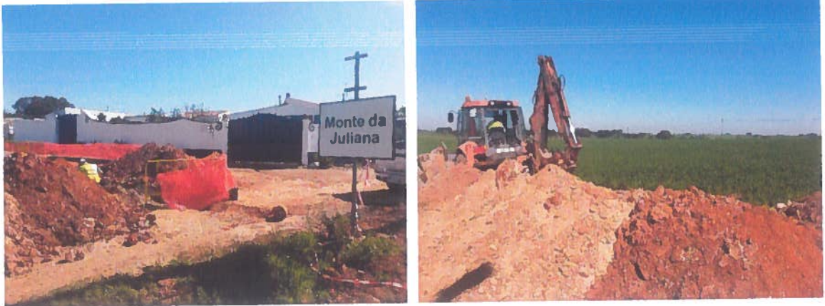
Movimentações de terras em diferentes pontos da obra.
