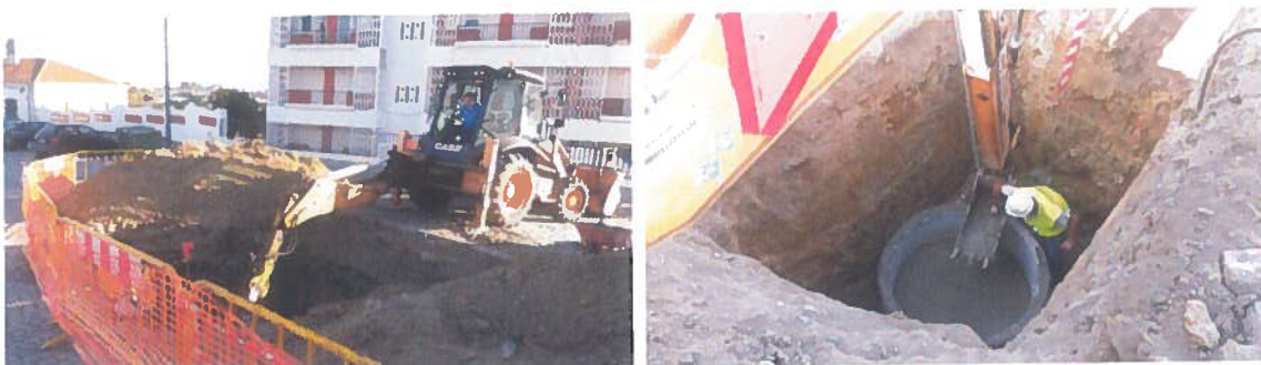
Levantamento de caixas de visita na Estrada Nacional 121 em Beringel;
