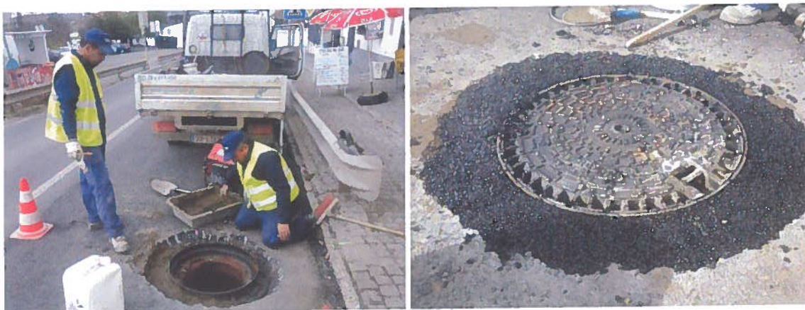
Trabalhos de colagem do aro à esquerda e trabalho já terminado à direita.
