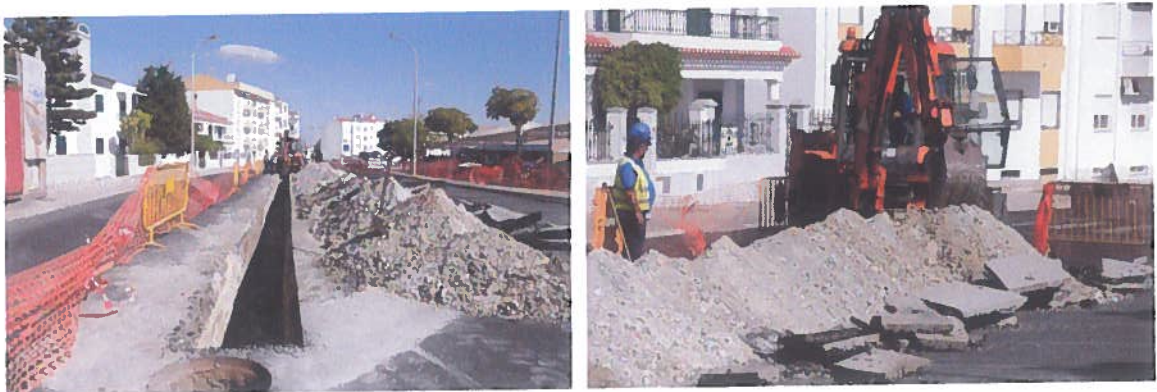
Abertura da vala para construção do coletor pluvial.
